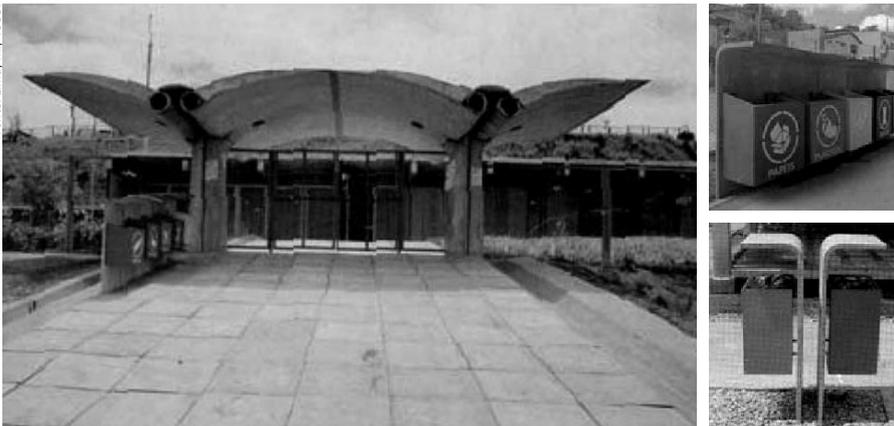
Figura 31. Componente de abrigo de ônibus fabricado no CEDEC, usado em composição para formar cobertura de entrada de escolas de argamassa armada.
