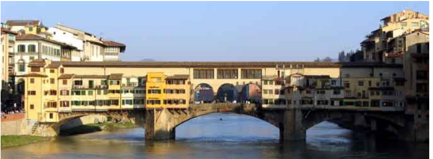
Florença, Ponte Vecchio. (fonte arquivo do autor)
